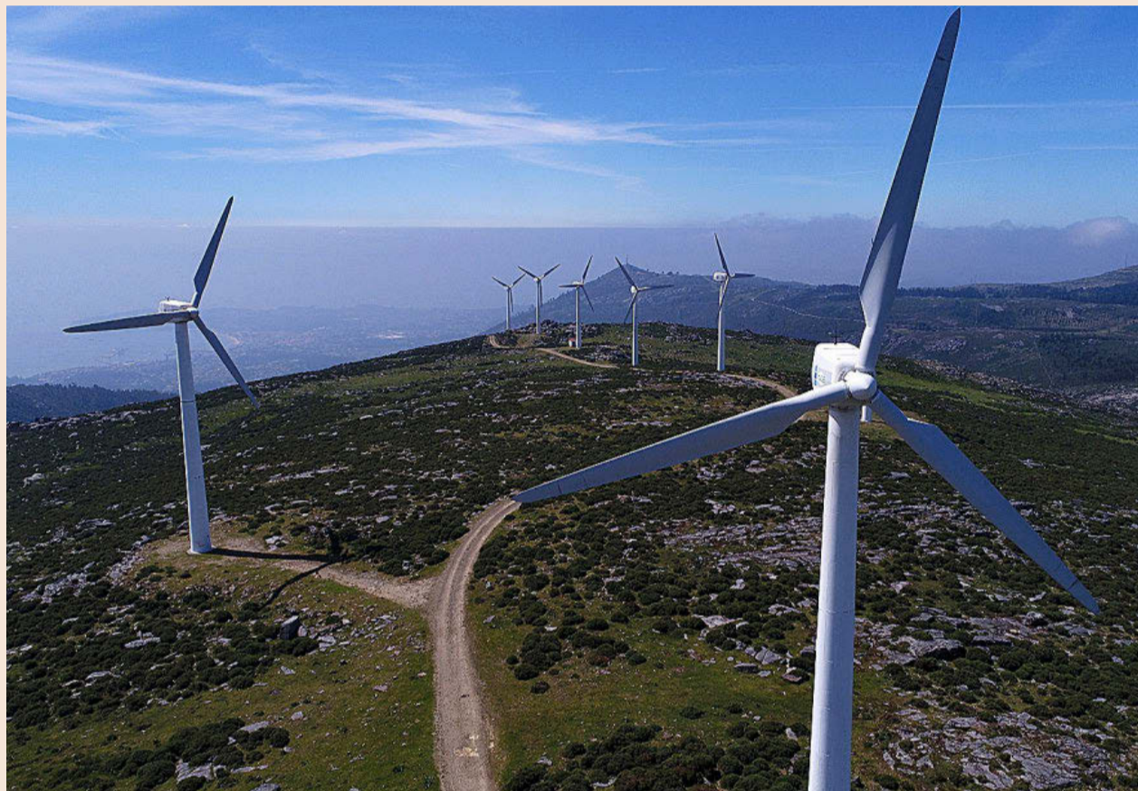
Imagen de aerogeneradores en un parque eólico.
